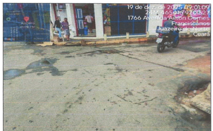
FOTO 06 - TAMPA DE CONCRETO, B1 E B2
